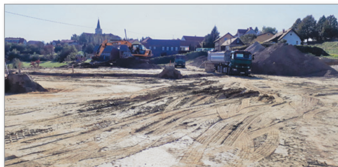
Pričetek gradnje – zemeljska dela v izvajanju
